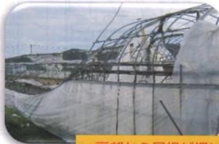
肩部から屋根が押しつぶされたように陥没
