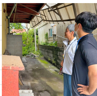
▲ 空き家の現地確認
