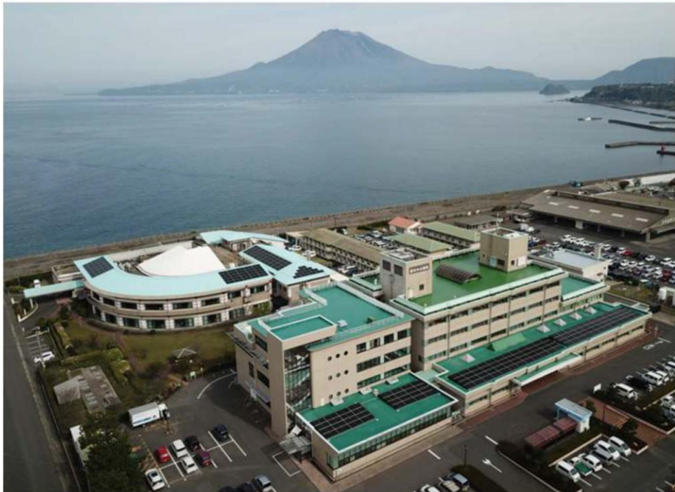
再生可能エネルギーを活用する公共施設及び太陽光発電設備 写真 垂水市
