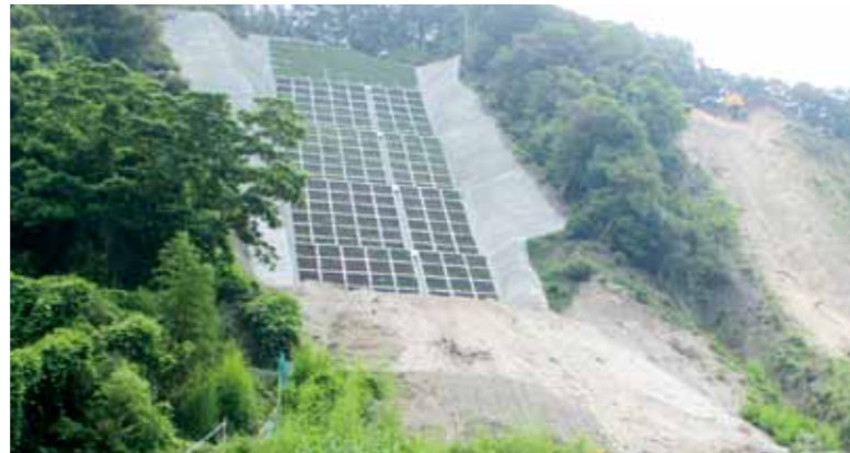
▲災害復旧工事が行われている現場（新城諏訪地区）
