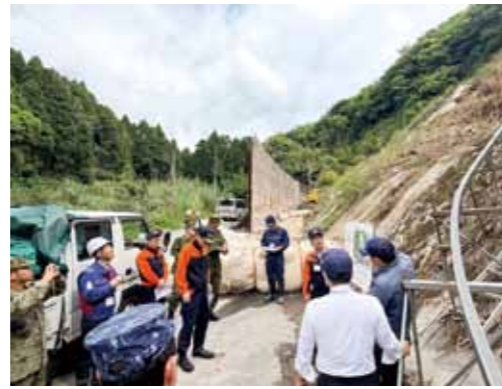
▲ 災害復旧工事現場点検
