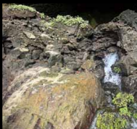
▲二階建て構造の足場部分
