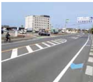
▲矢羽根設置状況(青い矢印マーク)
