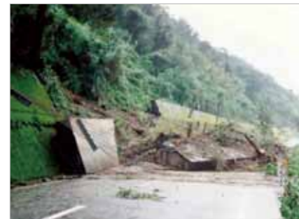
▲平成5年8月 国道への土砂流入
