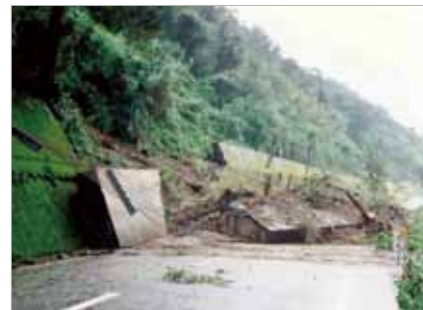
▲平成5年8月 国道への土砂流入
