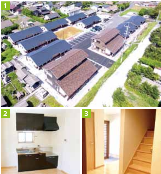
1／市営住宅中之平団地全景（2 階建：2 棟、平屋：8 棟） 2・3／内装の一部
