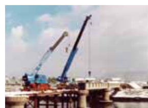
平成2年解体工事の様子
