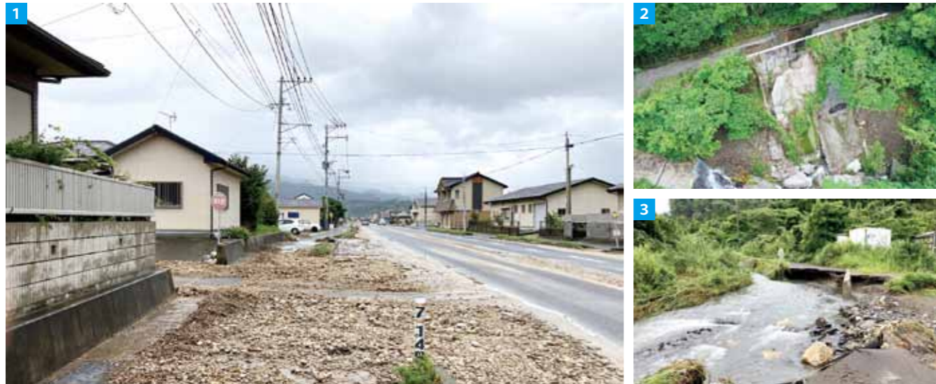
1 / 柘原地区国道土砂流出 2 / 高峠線路肩決壊の現場 3 / 中俣市木線路肩決壊の現場
