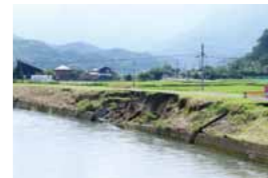
▲復旧工事前の様子(本城川牧橋上流)
