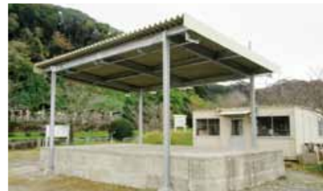
▶ 鉄道記念公園ステージに屋根を設置
