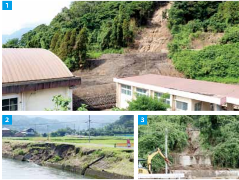
1／協和小裏の土砂崩れの跡 2／本城川（高城地区）堤防法面の崩壊 3／浜平鉄道線跡の土砂崩れ
