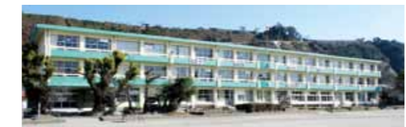
防災機能強化で外壁塗装などを行った垂水小学校校舎
