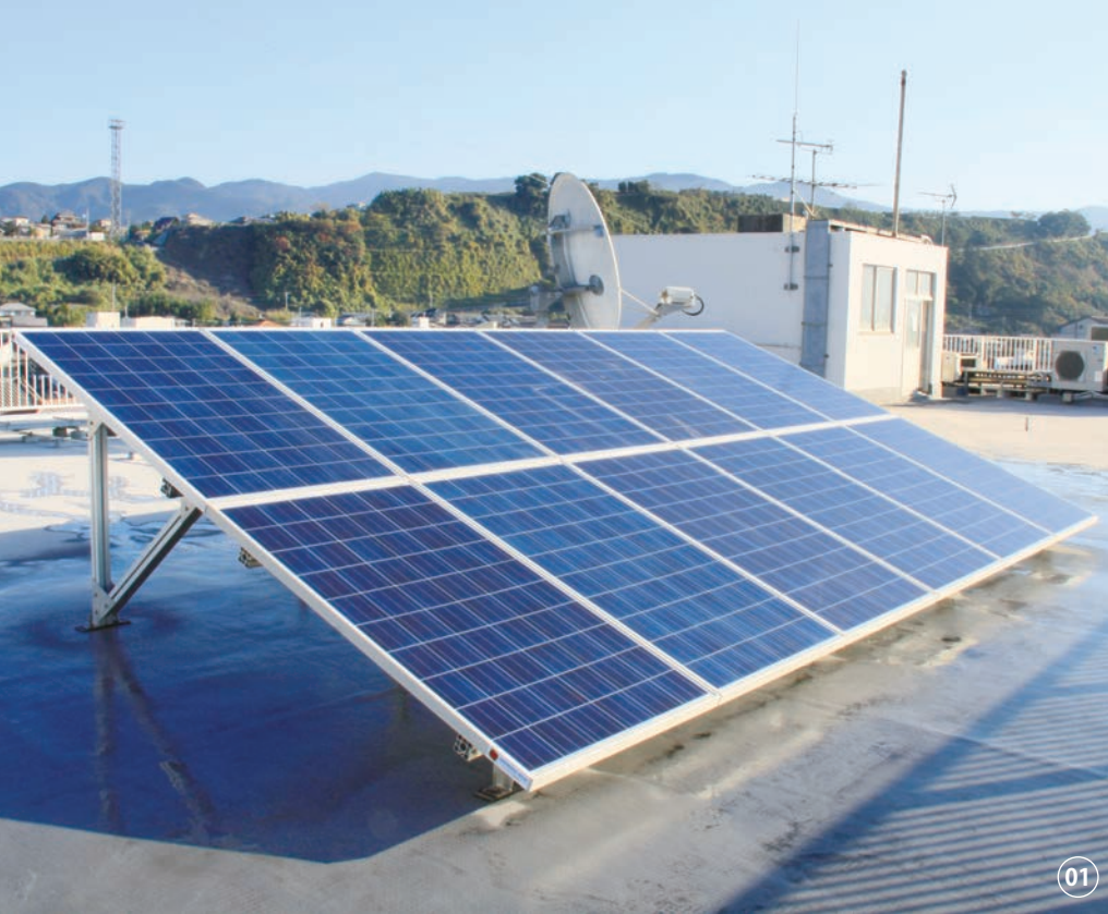
01 プロジェクトで使用されるソーラーパネル（12枚）が市役所屋上に設置され、市役所庁内の電気の一部をまかなっています（設置：平成24年10月2日／最大発電量：2.88kW／寄贈：リニューアブル・ジャパン株式会社／市役所本庁舎1階にモニターを設置し発電状況を確認いただけます）02・03 発電所建設予定地（市有地）（02 高峠つつじヶ丘公園近くの雑木林を整地した写真、03 高峠つつじヶ丘公園第3駐車場一帯）
