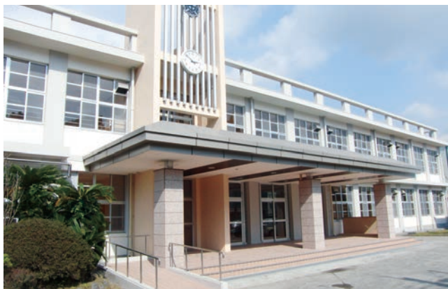
この事業では、教育環境整備の一環として、耐震補強と併せて大規模改造工事を垂水中央中学校で行うなどの事業を行っております。(広報たるみず平成24年5月号参照)
