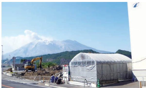
▲第2加工場の増設工事が進む現場
