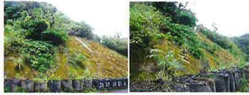
大字田神田上地内 市道元垂水原田線（法面防災工事）
