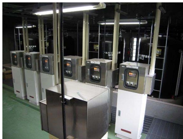
薬品注入機器
