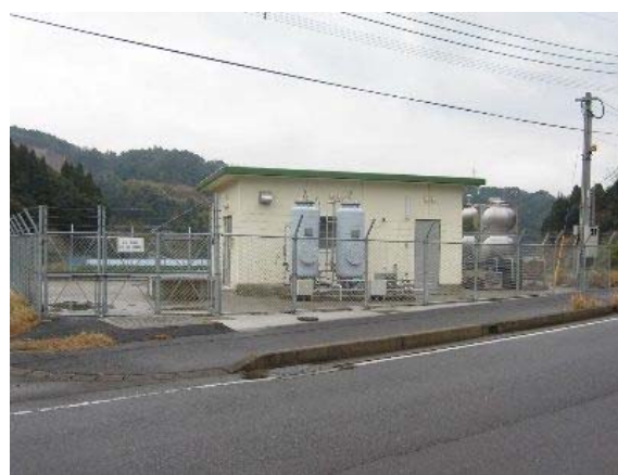
小谷・段ポンプ場
