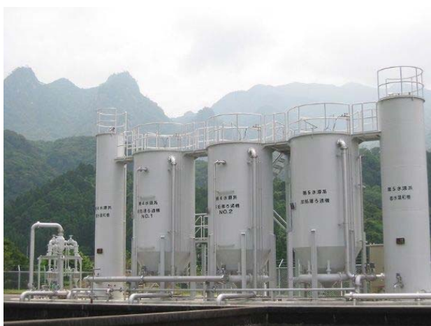
前処理機（内之野浄水場）
