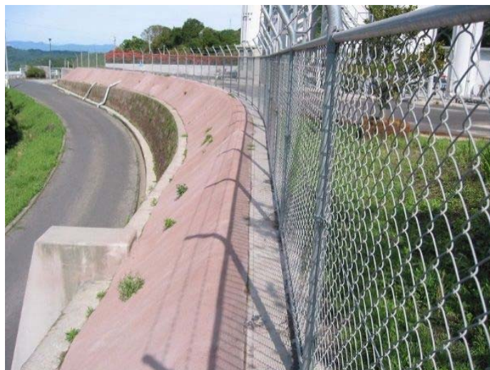
侵入防止フェンス（内之野浄水場）
