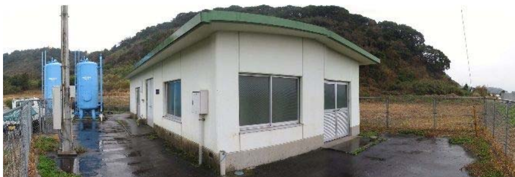
海瀉ポンプ場
