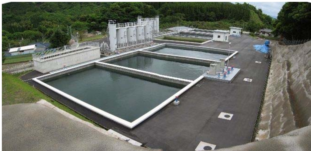
内之野浄水場
