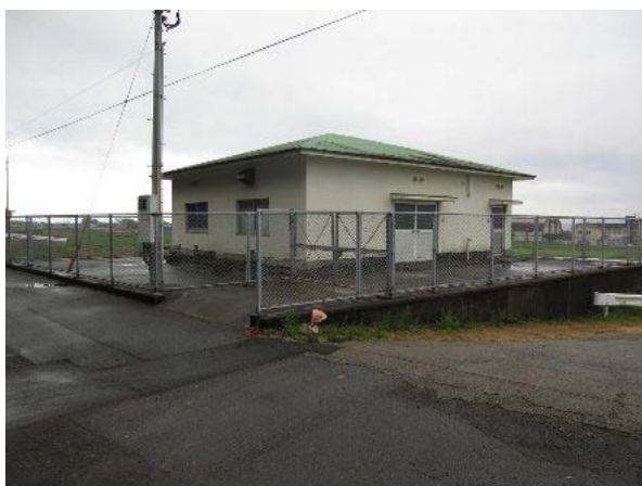
新城ポンプ場
