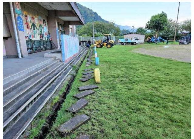
【④側溝の泥上げ】
