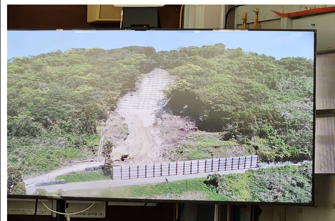
【崩落した協和小の裏山】
