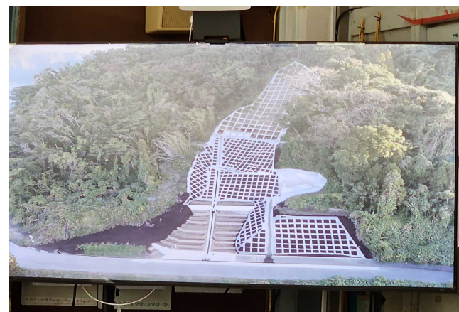
【工事完了後の裏山】
