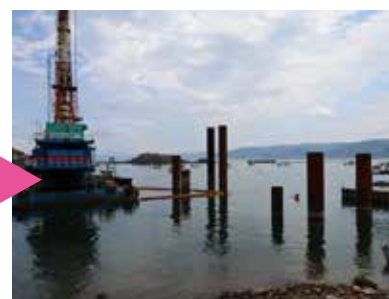
▲ 浮桟橋の整備現場（図の①）
