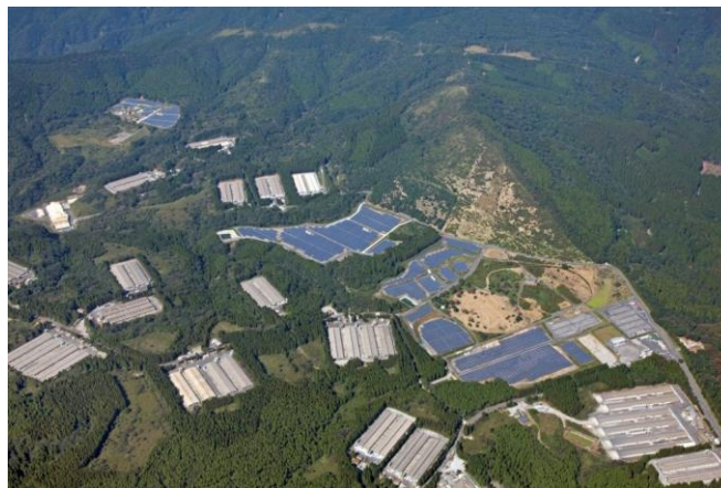
垂水市高峠太陽光発電所
