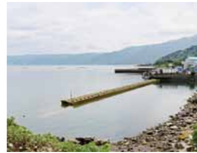
▲岸壁の整備現場（図の②）
