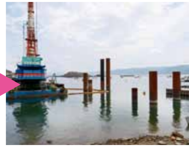
▲浮棧橋の整備現場（図の①）
