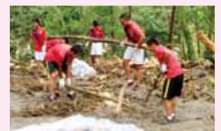
▲森の駅川沿いの復旧作業の様子
