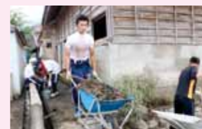
▲家屋の復旧作業の様子
