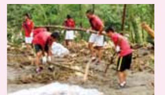
▲森の駅川沿いの復旧作業の様子
