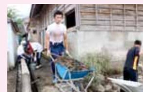
▲家屋の復旧作業の様子
