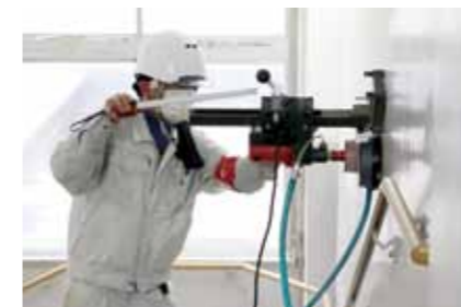
▲コンクリートのコア抜き
