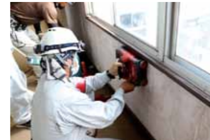
▲探知機で鉄筋の位置を確認
