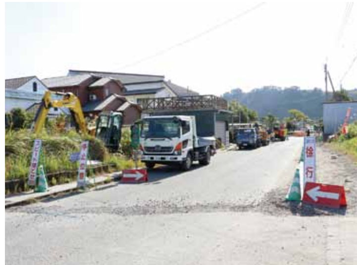
▲市道中洲線の工事の様子
