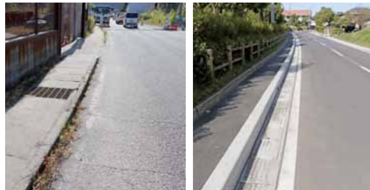
▲左/工事される前の歩道、右/工事後のきれいに整備された歩道
