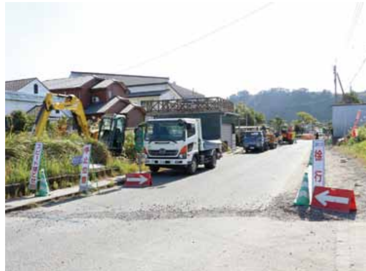
▲市道中洲線の工事の様子
