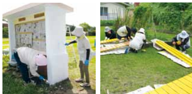
↑左：新城小の掲示板ペンキ塗り、右：終原小の側溝板蓋作り
