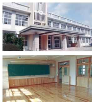
◎平成 23 年度に実施した中央中学校の大規模改造工事
