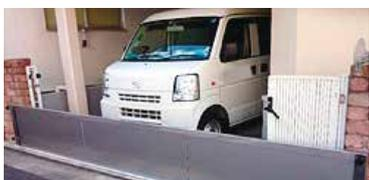
住家への浸水を食い止める止水板
