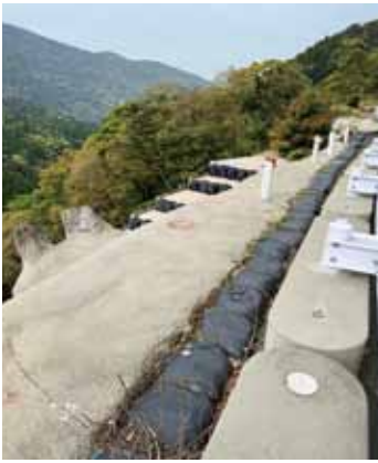
県道72号線拡幅工事現場
